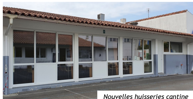
Nouvelles huisseries cantine
