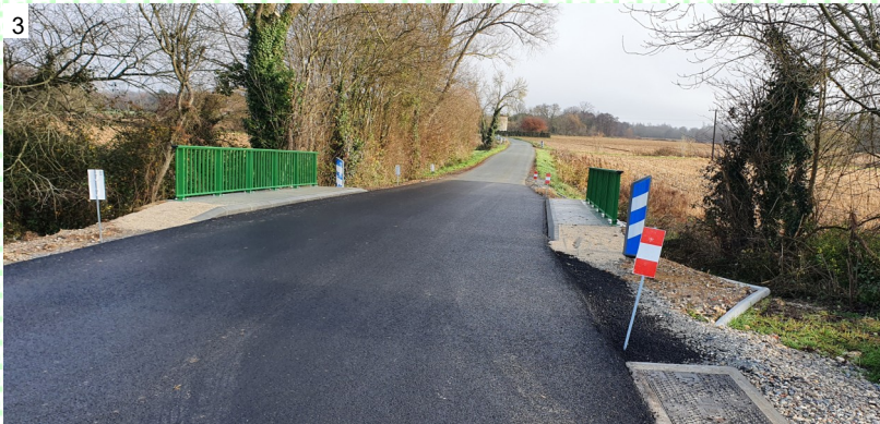
Nouveau pont de Chez Coicaud sur la RD216
