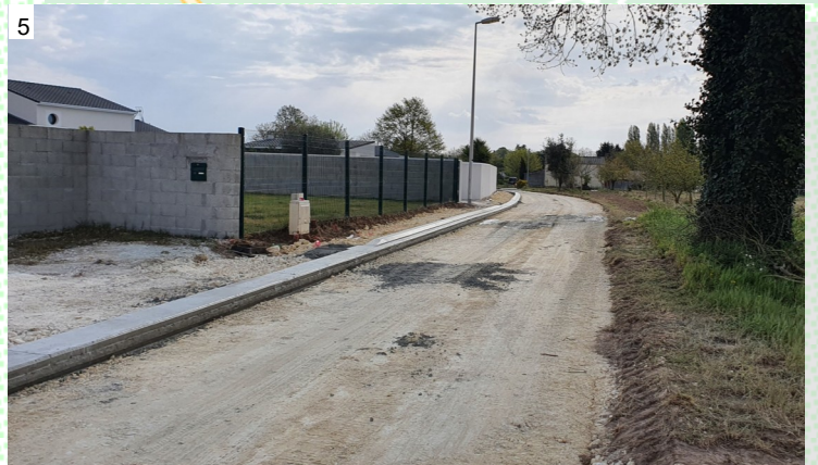
Réfection de la chaussée et des trottoirs rue de la Foy
