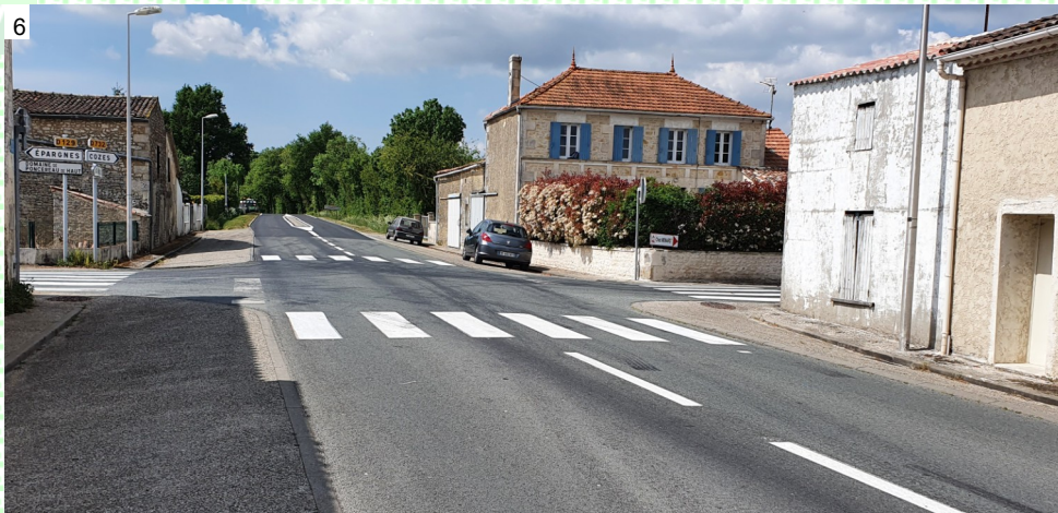
Réfection couche de roulement RD732 et nouveau marquage carrefour La Merletterie
