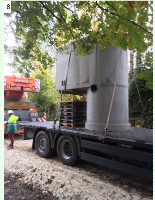
Mise en place du poste de relevage Chemin de Fraigne au Chaillaud
