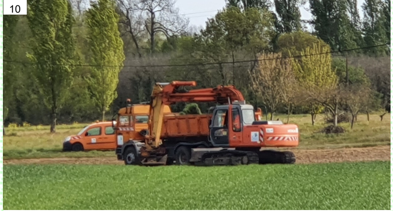
Nettoyage des fossés rue de Lidon
