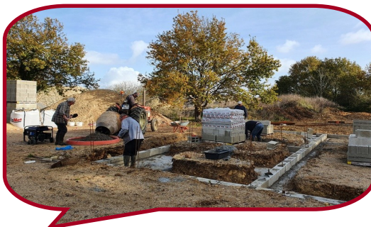
Fondations du local associatif
