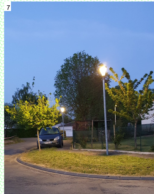
Eclairage public à La Cour du Bois
