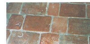
Les sols en terre cuite ou dalles de pierre sont à conserver. Il existe des produits les rendant plus faciles à entretenir. On peut aussi remplacer les éléments de sol les plus abîmés.
