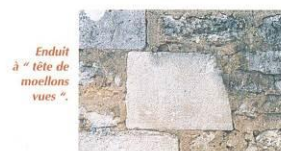
Avant de commencer tout enduit, il est indispensable de faire faire plusieurs échantillons et de les laisser sécher plusieurs jours. Il faut obtenir un échantillon pleinement satisfaisant avant de commencer le travail.
