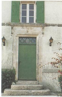
L'imposte vitrée éclaire le couloir. Les menuiseries sont un élément important de la composition des façades charrentaises, souvent très simples. Les ouvertures sont presque toutes superposées et plus petites aux étages.
