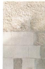
Il ne suffit pas de remplacer une pierre par n'importe quelle autre pierre pour obtenir un résultat beau et durable.
