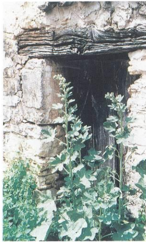
Tous les matériaux étaient tirés du sol environnant : terre cuite des tuiles, moellons de calcaire liés au mortier de chaux et sable. La végétation locale, ici une rose trémière, habille et égale les abords.
