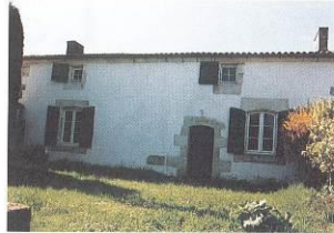
Habitation en moellons, à étage-grenier bas, percée d'ouvertures petites et irrégulières.
