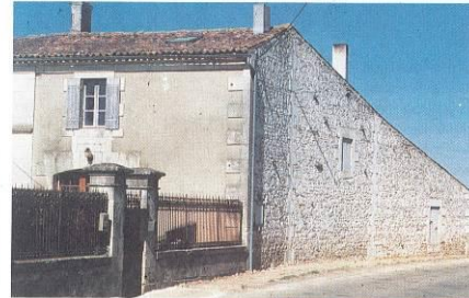
La façade principale orientée au sud, les dépendances sont accolées au nord sous un long pan de toit
