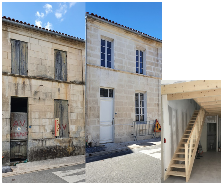
Avant/Après des travaux au 6, rue de l'ancienne gare
