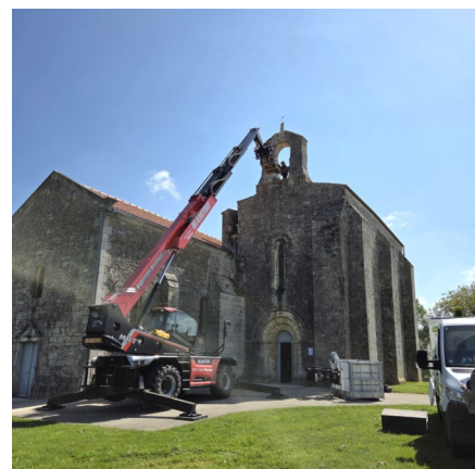
Remise en place de la cloche
