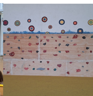
Mur d'escalade du préau équipé d'un revêtement amortissant les chutes
