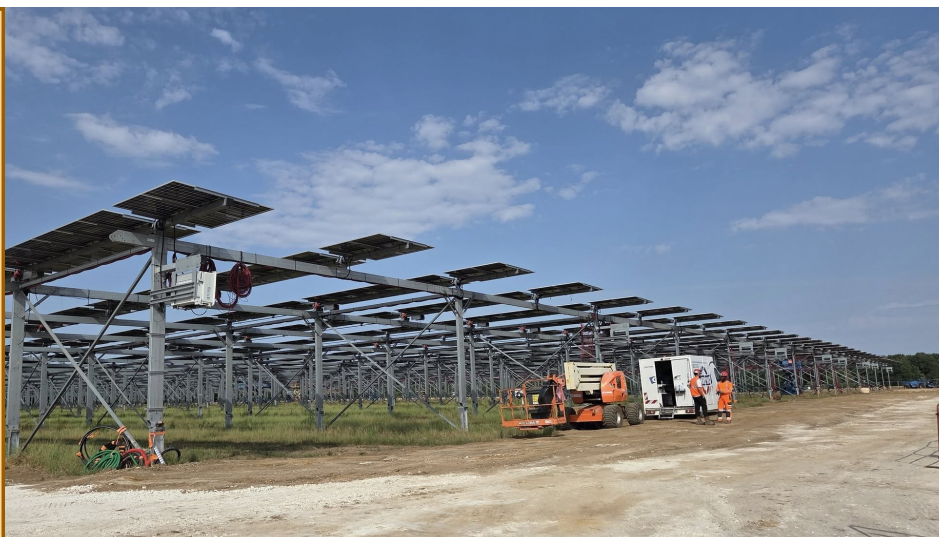
Chantier panneaux photovoltaïques et visite du chantier le 13 juin
