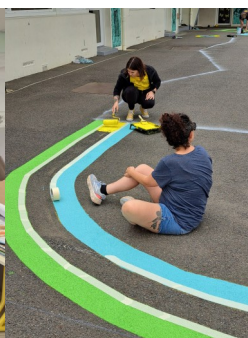
Peintures au sol 1er chantier participatif
