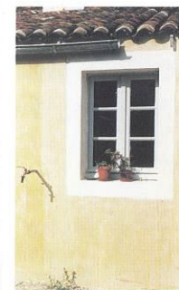
On peut colorer le badigeon avec des pigments afin d'obtenir des effets décoratifs et esthétiques. Avant toute application d'enduit ou de badigeon il est important d'effectuer des échantillons et de prendre le temps de les laisser sécher avant de faire un choix définitif.
