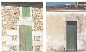
Ces moellons doivent être recouverts d'enduit.
