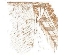
Support d'angle de la couverture dit "jambe de cheûn"
