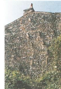
Conduit de cheminée tordu
