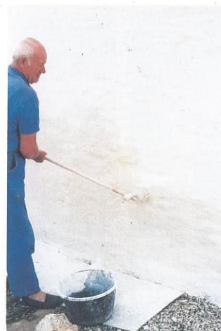
On peut colorer le badigeon avec des pigments afin d'obtenir des effets décoratifs et esthétiques. Avant toute application d'enduit ou de badigeon il est important d'effectuer des échantillons et de prendre le temps de les laisser sécher avant de faire un choix définitif.
