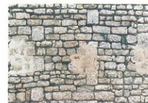
Avant de commencer tout enduit, il est indispensable de faire faire plusieurs échantillons et de les laisser sécher plusieurs jours. Il faut obtenir un échantillon pleinement satisfaisant avant de commencer le travail.
