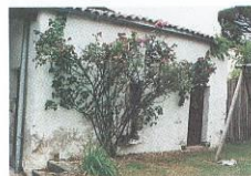
Un rosier habille cette façade très simple.
