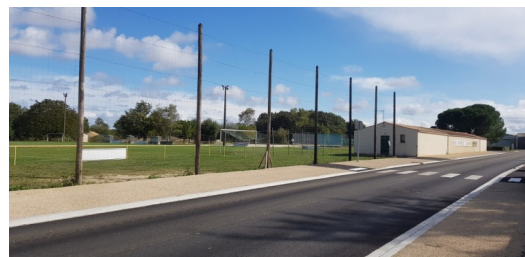
Vue dégagée sur le stade après le retrait des haies
